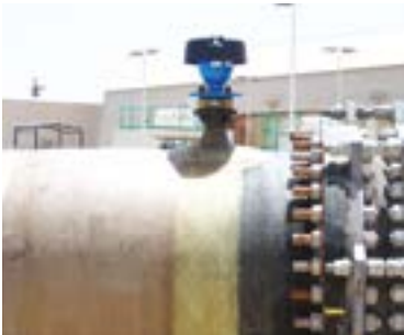
VÁLVULA DE AIREACIÓN TRIFUNCIONAL
