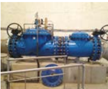
FILTRO CAZAPIEDRAS PARA PROTEGER UNA VÁLVULA HYDROBLOC
