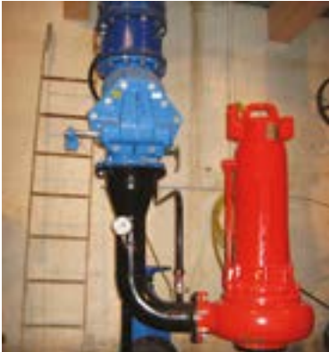
VÁLVULA DE RETENCIÓN A CLAPETA CON CONTRAPESO
